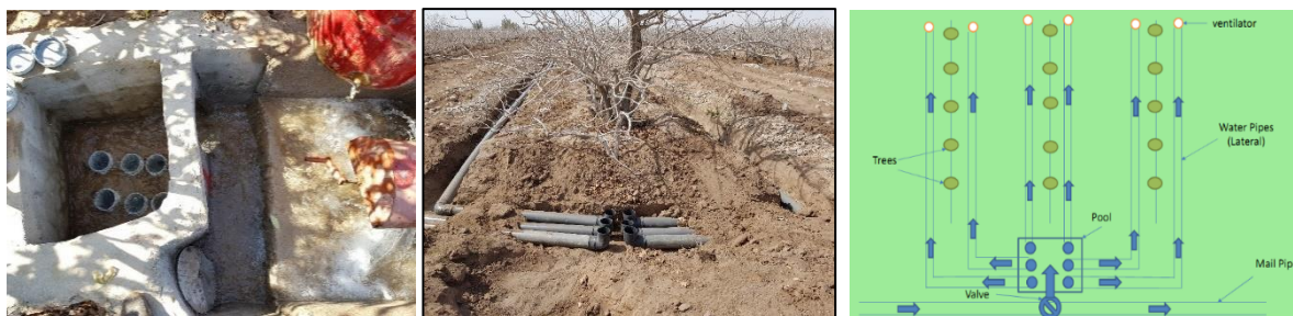
شکل ۲- نمای کلی از آرایش سه ردیفه آبیاری زیرسطحی کم‌فشار با لوله‌های پی‌وی‌سی و تصاویر مراحل اجرای این روش در باغ
