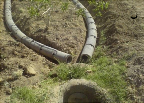
شکل ۹- وضعیت نصب و استقرار لوله‌های زیرسطحی سیمانی در کنار درختان پسته (شکل الف) و در ردیف‌ها (شکل ب).
