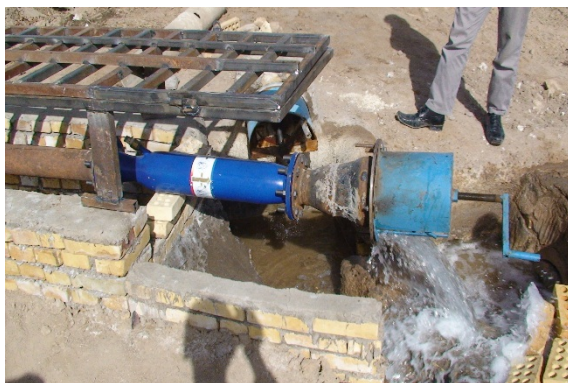
شکل ۲- نمونه دستگاه مغناطیسی کننده آب مورد استفاده در این پژوهش و وضعیت استقرار آن در مسیر جریان آب
