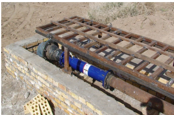
شکل ۲- نمونه دستگاه مغناطیسی کننده آب مورد استفاده در این پژوهش و وضعیت استقرار آن در مسیر جریان آب
