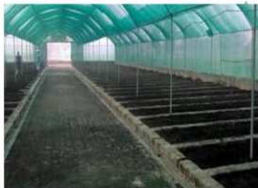
عکس ۲۰- شیار بندی برای خروج لجن فاضلاب
