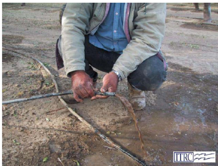
شکل (۷) - تجمع گل و لای و سایر رسوبات در انتهای لوله های فرعی و نحوه شستشوی آن
