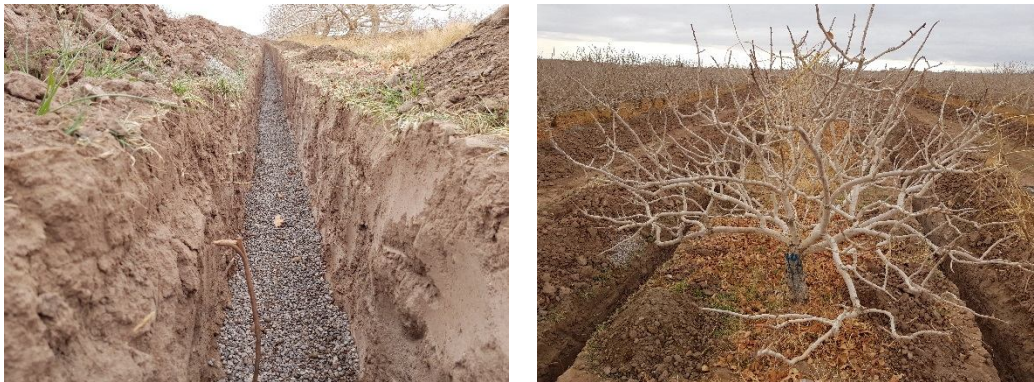
شکل ۸- نحوه حفر کانال یکنواخت با عمق مشخص و وضعیت تقریبی محل حفر آن را نسبت به ردیف درختان
