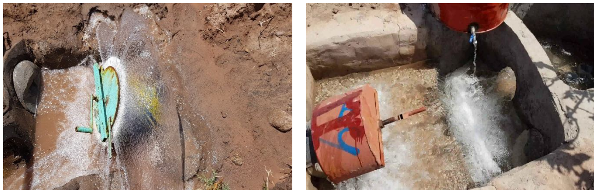
شکل ۱۷ - ریزش مناسب آب در حوضچه در دربندهای هندلی (راست) و پاشش آب به اطراف حوضچه در دربندهای معمولی (چپ)
