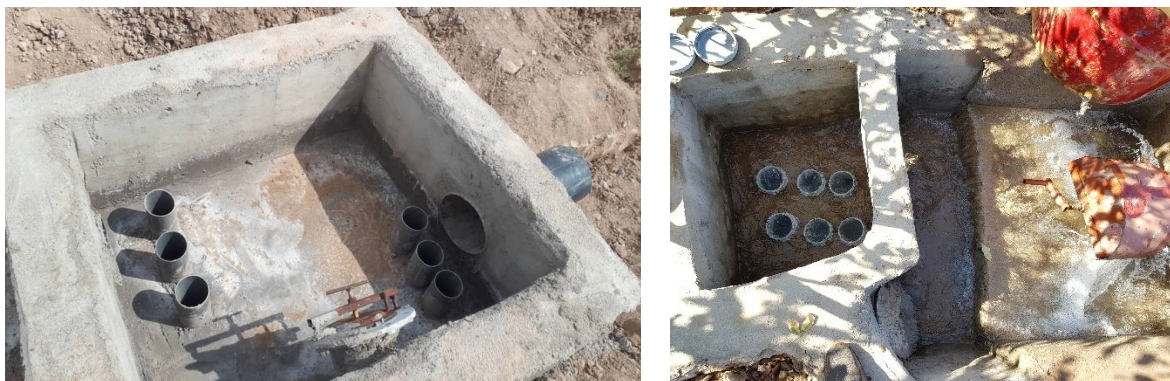
شکل ۱۳- نحوه طراحی حوضچه‌های آب در آبیاری زیر سطحی و آیشویی زمستانه در دو حالت اول (راست) و دوم (چپ)
