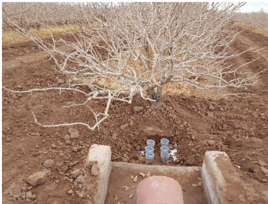
شکل ۲- وضعیت استقرار لوله‌ها در باغ نسبت به درختان، قبل و بعد از خاکریزی روی لوله‌ها
