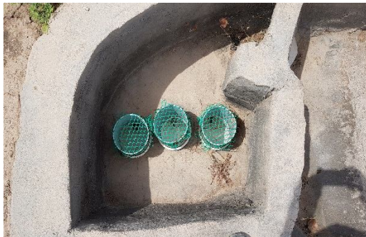
شکل ۱۹- نصب توری روی لوله‌های آبدار
