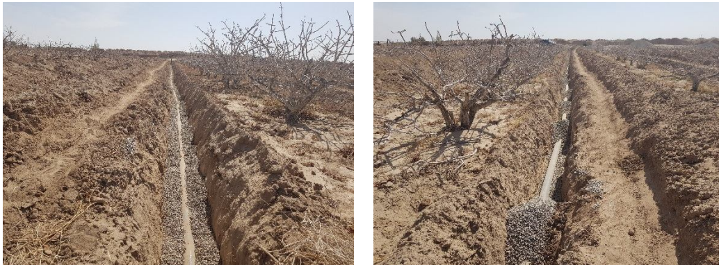
شکل ۶- نحوه ریختن فیلتر دور لوله‌های آبده و وضعیت نهایی آن‌ها پس از فیلترریزی کامل
