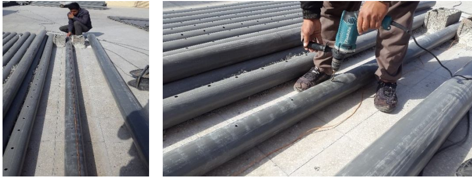
شکل ۱۰- نحوه سوراخ کردن لوله‌های آبیاری زیرسطحی
