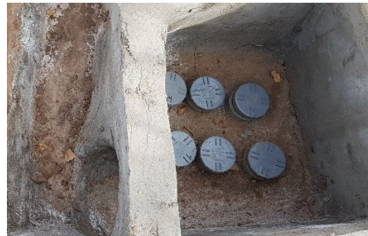
شکل ۱۸- درپوش‌های استاندارد روی لوله‌های آبدار
