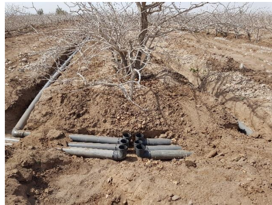
شکل ۲- وضعیت استقرار لوله‌ها در باغ نسبت به درختان، قبل و بعد از خاکریزی روی لوله‌ها
