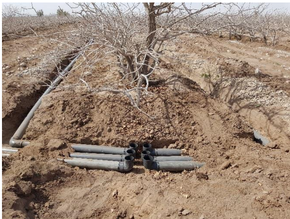
نحوه نصب و آبیاری لوله‌ها در سیستم آبیاری زیرسطحی کم‌فشار با لوله‌های PVC
