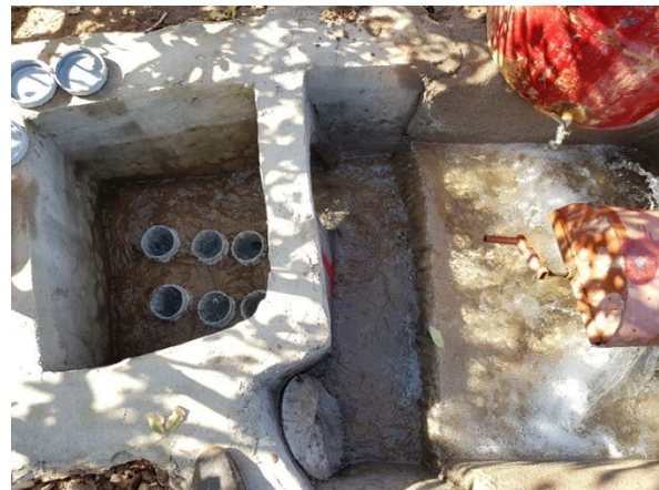
نحوه نصب و آبیاری لوله‌ها در سیستم آبیاری زیرسطحی کم‌فشار با لوله‌های PVC
